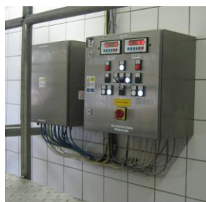
vážiaci systém ALYA pre zásobníkové technológie prevádzky potravinárskej výroby
